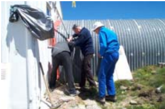
Travaux de plomberie...
