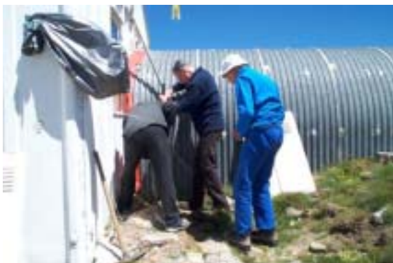
Travaux de plomberie...
